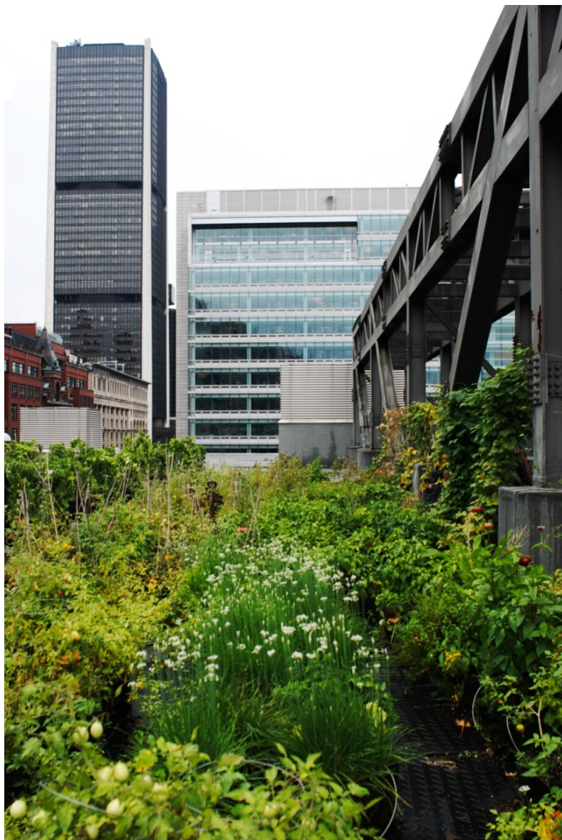
Figure I.3. Jardin installé sur un toit à Montréal, au Canada : le système combine bacs et murs végétalisés et vise à la fois à produire des aliments et améliorer la régulation de l'eau et de la chaleur des bâtiments (© G. Pulliat, 2018)
