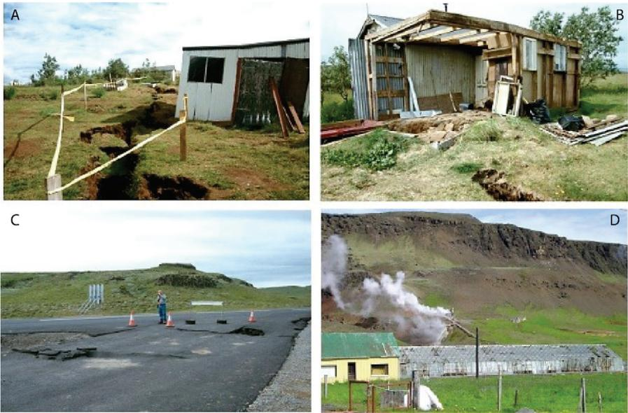
**Figure I.18.** Destructions lors des séismes de juin 2000 à Bitra (© Françoise Bergerat) : A, B) bâtiments de la ferme, C) route n° 1) ; et de mai 2008 à Hveragerði (© Brigitte Van Vliet-Lanoë) : D) canalisations disloquées et serres endommagées
